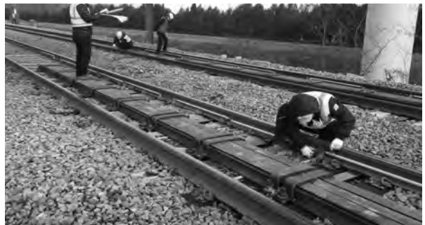
〈그림 11〉 계측센서 설치전경
