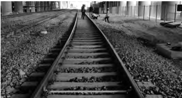
〈그림 18〉 △△△역 고가교 확장공사 현장
