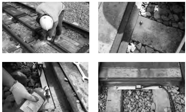
<그림 2> 기존 레일변위계 설치사례
