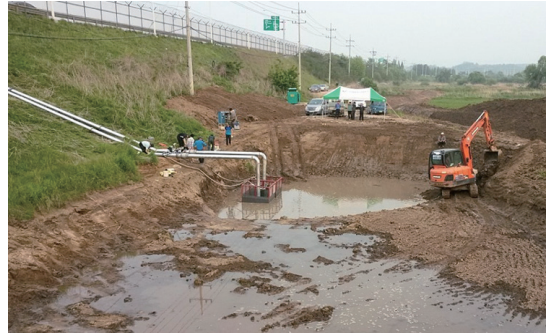
통일대교 임시양수장 설치
