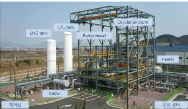
그림 3. LNG·극저온기계기술 시험인증센터 시험설비.
