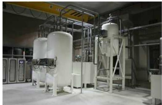
그림 1. 감압 방식 냉각시스템 (이천변전소).
