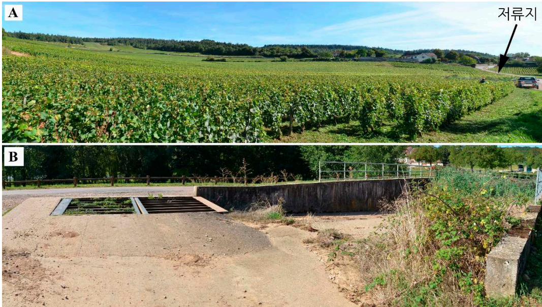
그림 9. 프랑스 부르고뉴 지역 개인 농가의 포도 재배지 및 토양 유실 방지 저류지
