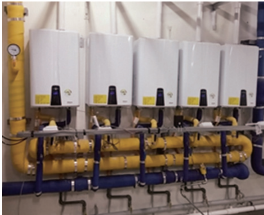
〔그림 4〕 멀티 보일러 설치
