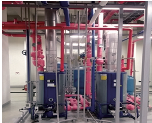
〔그림 5〕 중형 보일러 설치
