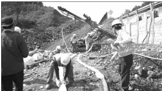
그림 4. 팍 앵커 시험 시공
