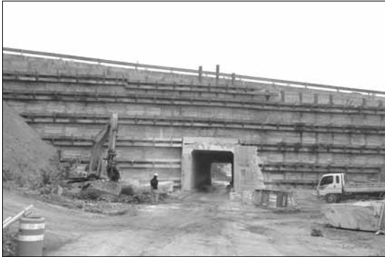
그림 5. 시공 완료된 유하교 가시설
