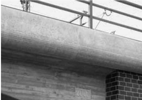
〈25. 날개벽과 아치의 각도를 일치시키고 있다. 안전난간을 성토체까지 연장하였으므로 날개벽 위에 안전난간을 추가로 설치할 필요가 없게 되었다.〉
