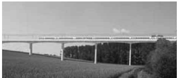
〈1. 고속 신선 에어푸르트-할레·라이프치히 간〉 Scherkondetalbrücke 2010
