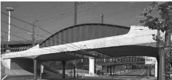
<17a-웹브 테두리 형상에 의해 힘의 흐름이 명확한 스큐 플레이트 거더교. 셋백시킨 교대와 강제 교각에 의해 개방적 형하 공간을 연출>
