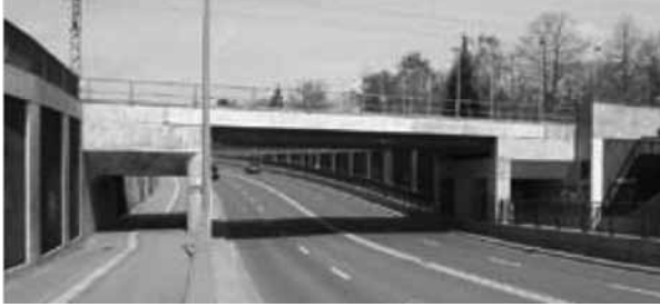
<15. 전체가 상부공과 보행자용으로 옆에 배치된 라멘으로 분할되어 버렸다. 상부공과 역 플랫폼 입구. 일정한 형고와 수평 코니스(cornice)를 가진 3경간 구조가 혼재되어 있다.>
