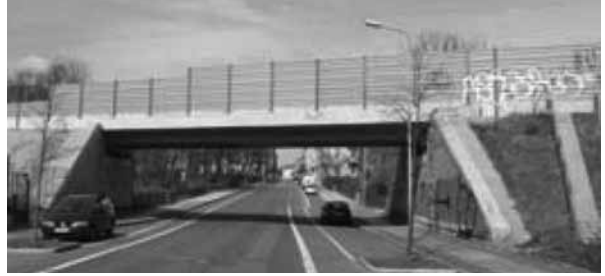
<16. 이러한 구조의 경우 높이를 가지런히 한 투명 방음벽을 사용하고 점검로 계단을 날개벽과 평행 하게 배려함으로써 보다 명쾌한 디자인이 된다.>
