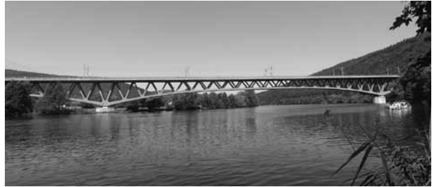
〈3. Nantenbach Bridge (마인교)〉
