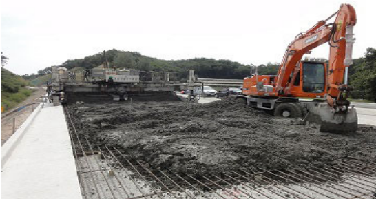
(b) CRCP 시공 현장
