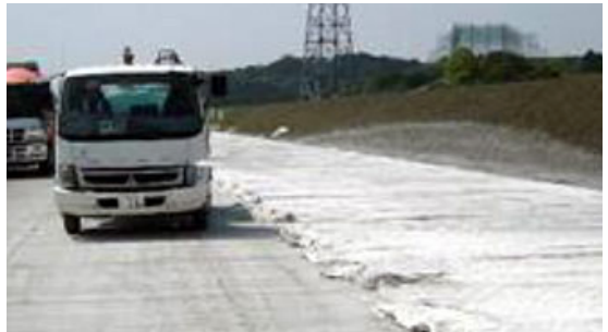
그림 2. 시멘트콘크리트 포장 습윤양생(일본)
