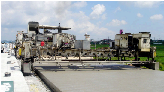
(a) JPCP 시공 현장
