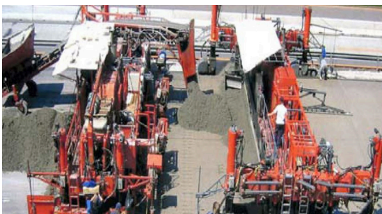
그림 3. 2층 시멘트콘크리트 포장의 시공 전경
