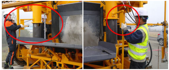
그림 12. 배근 위치 확보 및 모니터링용 계측바 설치 전경
