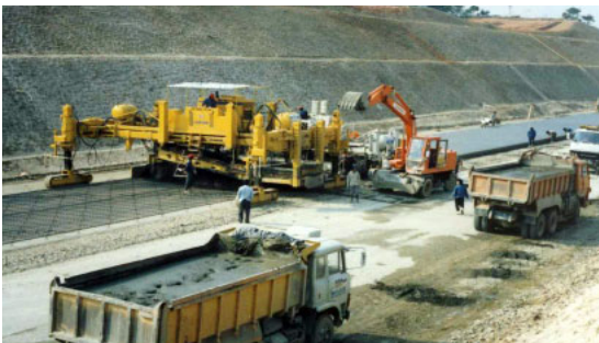
그림 3. 중부고속도로 CRCP포장시공 전경(1986년)
