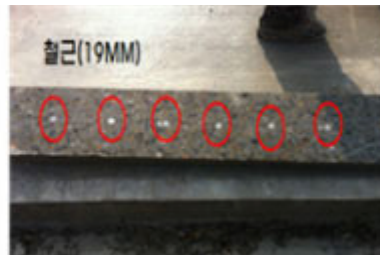
그림 14. 시험시공 및 철근 배근상태 확인 전경
