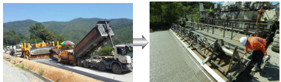
2. 철근배근 동시 콘크리트 포설
