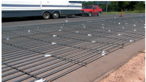
그림 6. 철근 배근 후 전도(온도영향)
