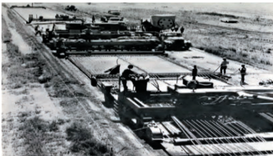
그림 8. Tube Feeding 적용 시공 전경
