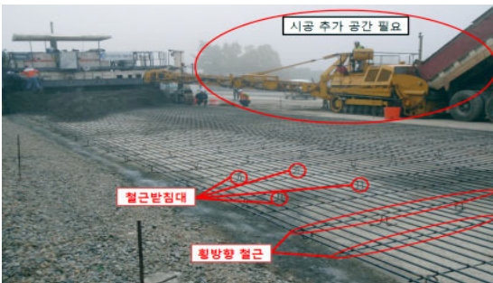
그림 4. 음성~충주간 고속도로 CRCP포장시공 전경(2012년)
