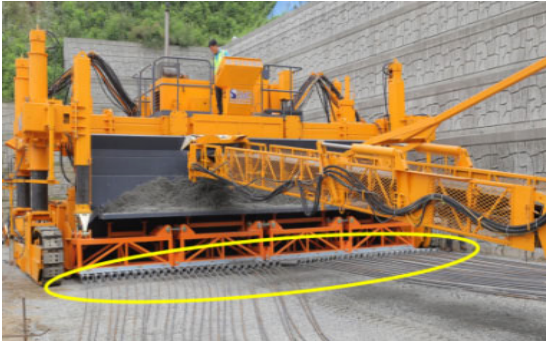
그림 9. 튜브 곡률(휨 형상 설치) 배치 전경
