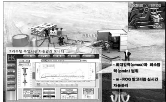
그림 15. m-ROG 기반 주입시공 자동관리 및 모니터링
