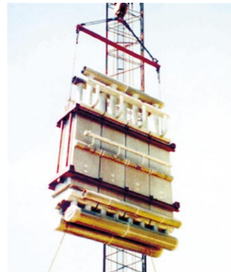
[그림 7] 극저온용 플레이트 핀 열교환기 외형(좌), 콜드박스에 장착되고 있는 모습(우)
