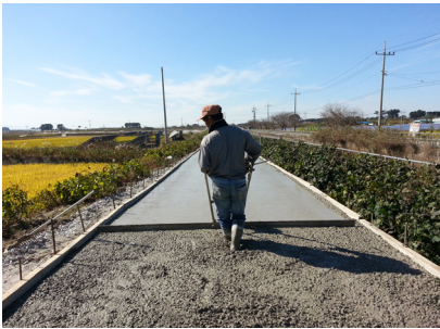
(d) Finishing work
