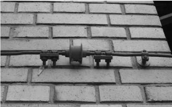
그림 3. 방전궤를 이용한 피뢰등전위본딩 사례
