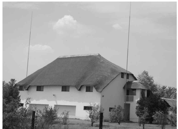
그림 3. 구조물과 분리된 외부 LPS 시공 사례
