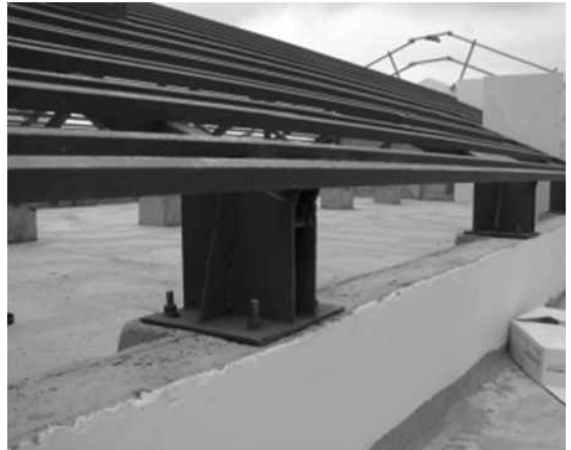
그림 9. 자연적 피뢰도선으로 사용 가능한 경량철골
