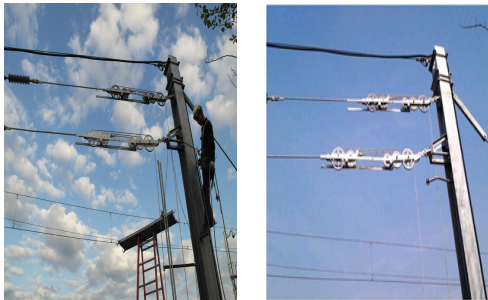
그림 8 구내 테스트베드 내 장력조정장치의 예비 시공 Fig. 8 Preliminary construction for the pulley type tensioning device in the in-house test-bed
