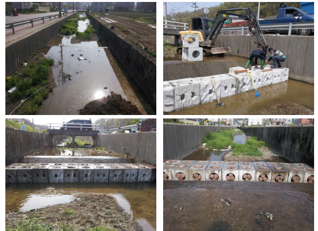
Fig. 4 Site test construction
