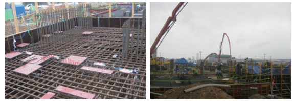
(a) 매립형 게이지 설치
