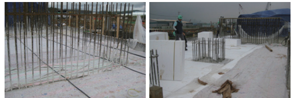
(c) 온수공급라인 시공
