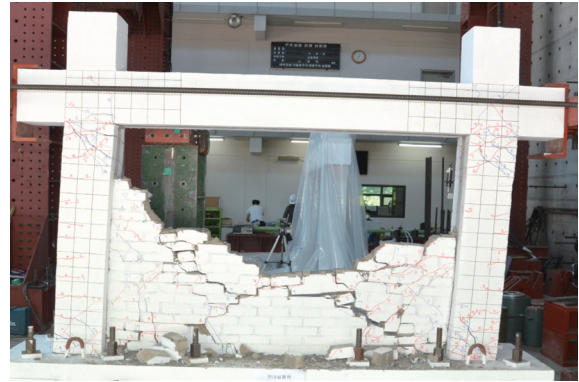
사진 2. 채움벽의 좌굴에 따른 면외붕괴
