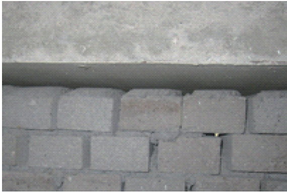
사진 1. 보하단과 채움벽 상단사이에서 발생한 공극의 예
