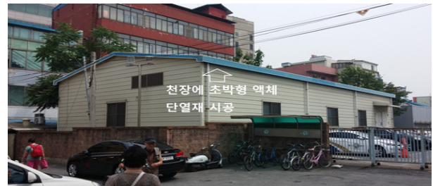
그림 2 철도 전기실 (사진: 천안역 전기실)
