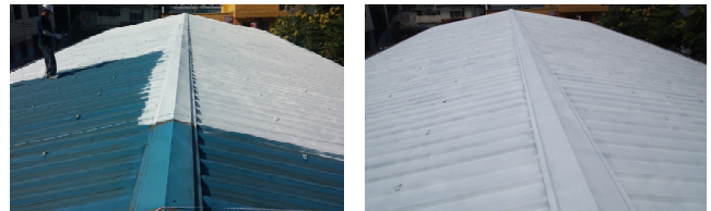
그림 4 천안역 변전소 옥상 단열 시공
