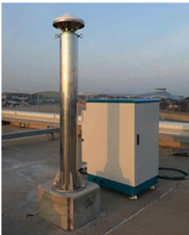
그림 19. 전파위협 수신국 설치 결과
