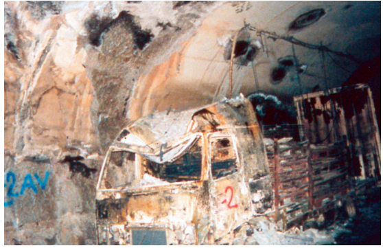
(b) Mont-Blanc Tunnel
