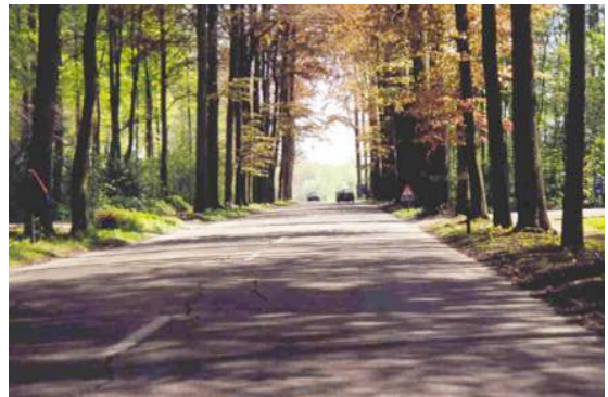
그림 1. 1925년에 건설된 콘크리트 포장 도로 (Drève de Lorraine in Uccle)
