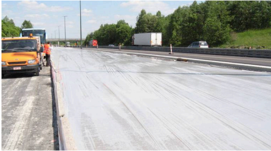
그림 10. 비닐막에 의한 양생 전경
