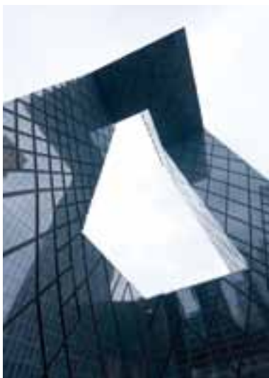
CCTV를 올라다본 모습
