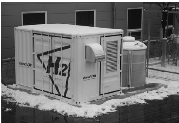
[그림 5] 50kW/100kWh VRFB ESS 설치사진(충남, 공주)
