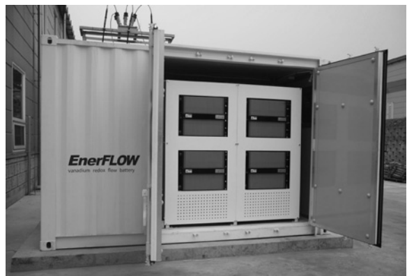
[그림 5] 50kW/100kWh VRFB ESS 설치사진(충남, 공주)
