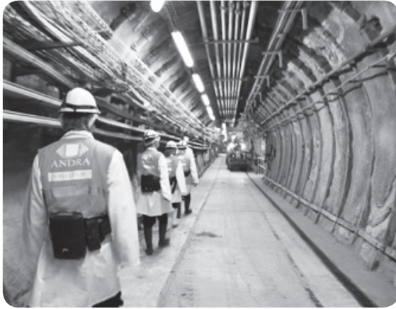
프랑스 부루 지역에 위치한 방사성폐기물 심층 처분 시험 시설의 지하 500m 동굴 내부
