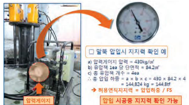
[그림 5] 시공중 연직지지력 확인 예
