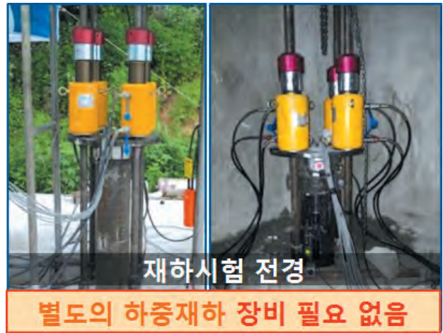
[그림 12] 압입장치를 이용한 재하시험 전경
