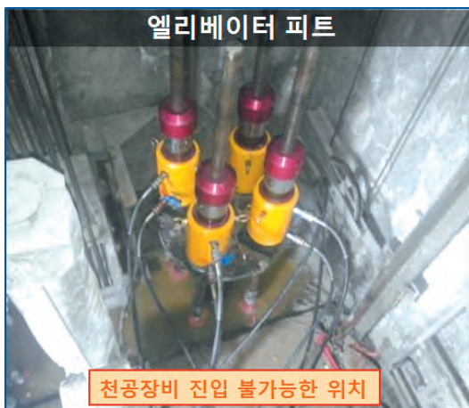
[그림 4] 제한된 공간에서의 시공사례
