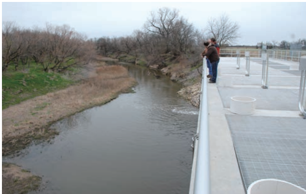
▶ 캔자스 주 위치토시에 위치한 대규모 지하수 인공함양시설(좌: 하천으로부터의 취수장면, 우:수처리 후 급수과정)
