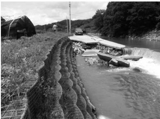
〈그림 1〉 연천군 폭우로 인해 안전한 식생바구니 적용제방과 유실된 기존 제방의 비교 모습(2013.07)
