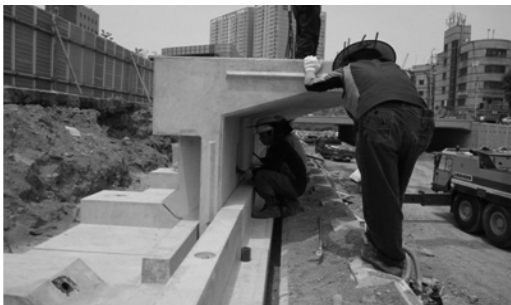
하천측 자전거 도로 확장
