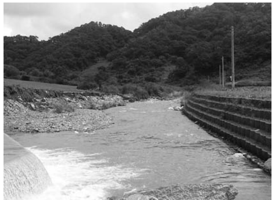
〈그림 2〉 연천군 폭우로 인해 안전한 식생바구니 적용제방과 붕괴된 맞은편 기존 제방의 비교 모습(2013.07)
