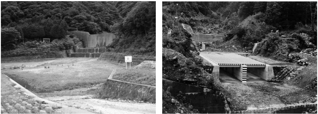
그림 3. 산록지역의 사방공사에 유효하게 활용될 수 있는 유사지와 바닥스크린의 시공사례
