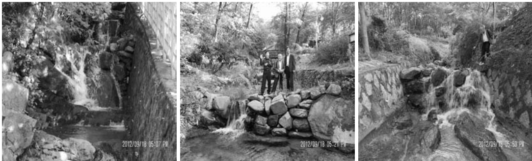
누수식 생태보 설치 현황
