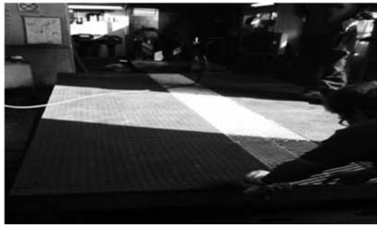
교량 구조물과 고무판 접합
