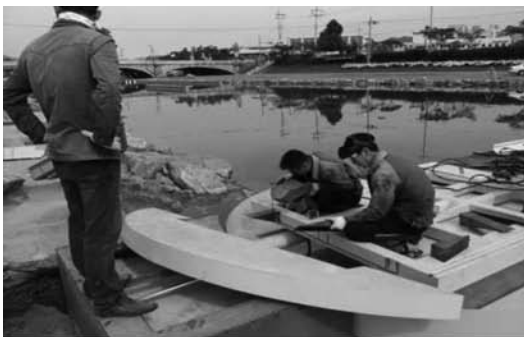
교량 상판 고무판 조립
