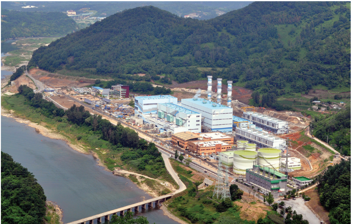
[그림 1] 국내 최초로 화력발전분야에서 KEPIC을 전면 적용해 건설된 영월천연가스화력발전소
