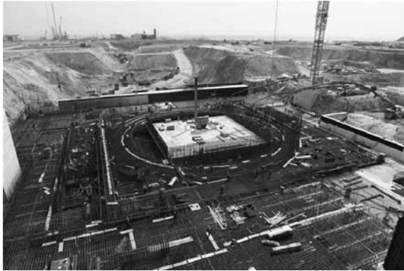
[그림 3] 원자로건물 기초 전경
