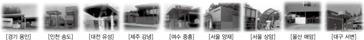
[그림 9] 국내 자동차용 수소스테이션 설치현황[출처 : 현대자동차(2014)]
