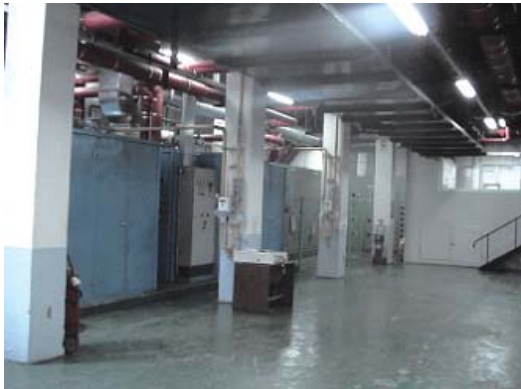
대전 신동아아파트 설치 열병합발전시스템
