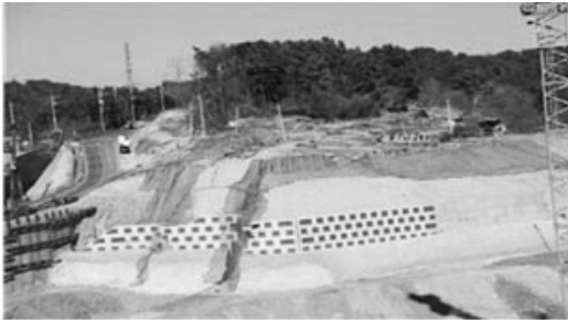
- 진동에 의한 전단강도 저하로 사면부 대규모 붕괴 - EJP 앵커 공법을 적용, 붕괴구간 응급복구를 실시하여 시공완료
