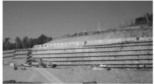
- 진동에 의한 전단강도 저하로 사면부 대규모 붕괴 - EJP 앵커 공법을 적용, 붕괴구간 응급복구를 실시하여 시공완료
