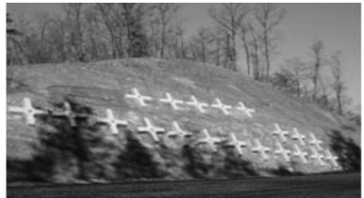
- 사면부의 풍화, 미고결 점토 협재 및 파쇄대 구간 대책공법 필요 - EJP 앵커 공법을 적용하여 사면보강 완료
