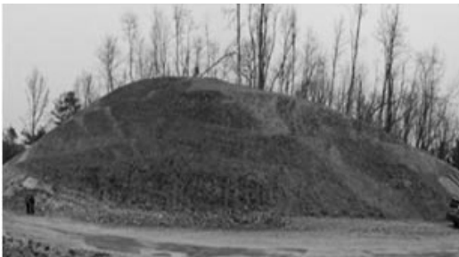
- 사면부의 풍화, 미고결 점토 협재 및 파쇄대 구간 대책공법 필요 - EJP 앵커 공법을 적용하여 사면보강 완료
