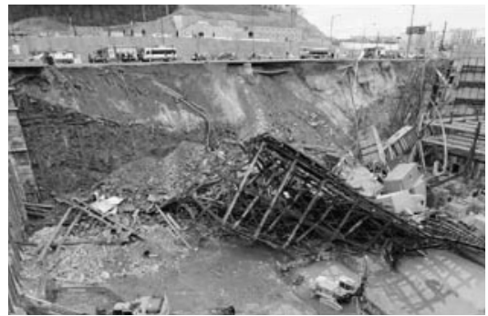
그림 3. 사면 및 흠막이 붕괴 현장
