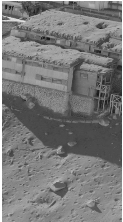
그림 2. 온타케 화산에서 튀어나온 분석 발사체들이 남긴 충격흔적(지붕에 구멍이 나있고, 화산재위에 충격흔들이 보인다. 동경대지진연구소공개자료)
