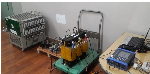
그림 5 고조파 측정 시험 장치 Fig. 5 Test apparatus for harmonic measuring
