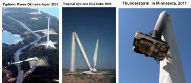
그림 1 Buckling Failure of Steel Tower
