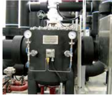
[그림 12] 오토스트레이너 설치 현황
