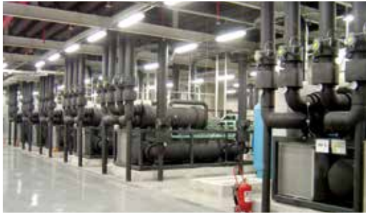
[그림 9] 히트펌프 설치 현황
