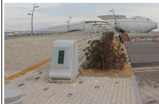
현황 2 수니교-수변공원-여니교로 이어지는 투어 전기차 동선의 바닥의 패턴이 차도와 보도의 분리가 되지 않고 난간 쪽으로 가까이 붙어 그려진 노란 선이 유용하지 않음
