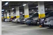
현황 4 지하주차장 바닥은 콘크리트 미장 그대로 사용해서, 분진과 같은 환경 저해 및 바닥 유지관리에 문제가 있음
