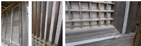
<그림 1> 『제천 김세균고가』 마루방의 세살창호 (창호 외관(左), 창살(中) 및 문올거리 부분(右))
