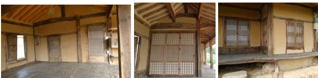
<그림 10> 안채 골방과 건넌방의 세살청판 창호 <그림 11> 사랑채 대청의 들어열개 <그림 12> 사랑채 큰사랑과 방의 머름
