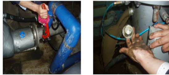
그림 1. 공구를 이용한 센서 탈착 및 배관내 슬러지 유출 Fig. 1 Removal sensors using tools and discharging of sludge from the pipeline
