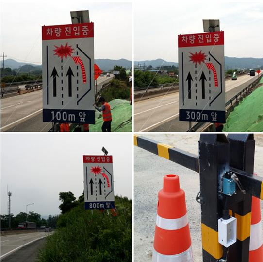
그림 10. 사전 자동경고 주의표지 및 감지센서 설치 완료
