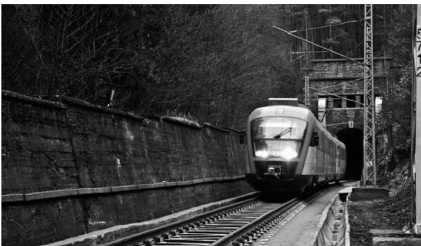
<그림 12> 불가리아 Bunovo 지역 3번 터널 아스팔트 노반 궤도 교체 시공 전후
