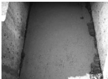
<그림 5> GETRAC A1 궤도의 침목 사이 아스팔트 노반 표층 상태
