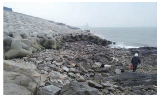
사진 1. 인천지역 부지조성공사 현장 전경
