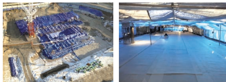
(a) 외부 양생 전경 (b) 내부 양생 전경
