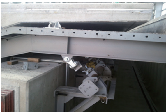
사진 1. 외부 몰드 탈형 시스템
